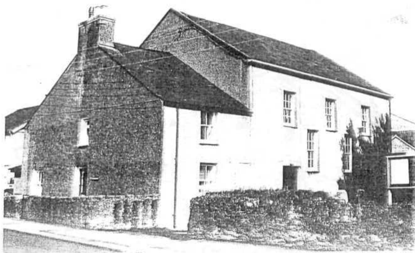
Llun / Photograph R.C.A.H.M.W.
